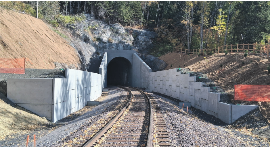
L'entrée refaite du tunnel à Port-Daniel-Gascons. Photo Anthony Bernard Price
