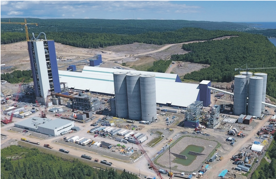
La cimenterie McInnis lors de sa construction. Photo courtoisie – archives
